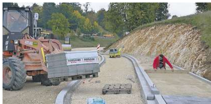
In diesem Bereich des Gronsdorfer Weges wird gepflastert.
